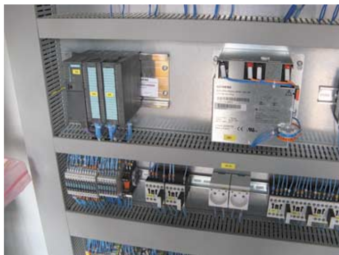
Рис. 5. Фрагмент монтажной панели с управляющим контроллером в изолированном электропомещении
