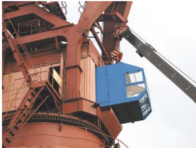
Рис. 6. Установка новой кабины машиниста на кран
