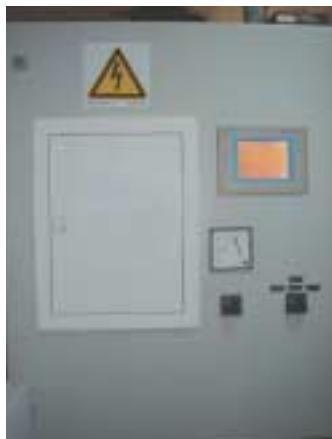
Рис. 8. Дверь распределительного электрошкафа (за креслом крановщика)
