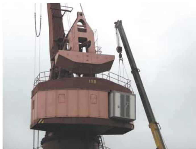
Рис. 4. Монтаж изолированного электропомещения
